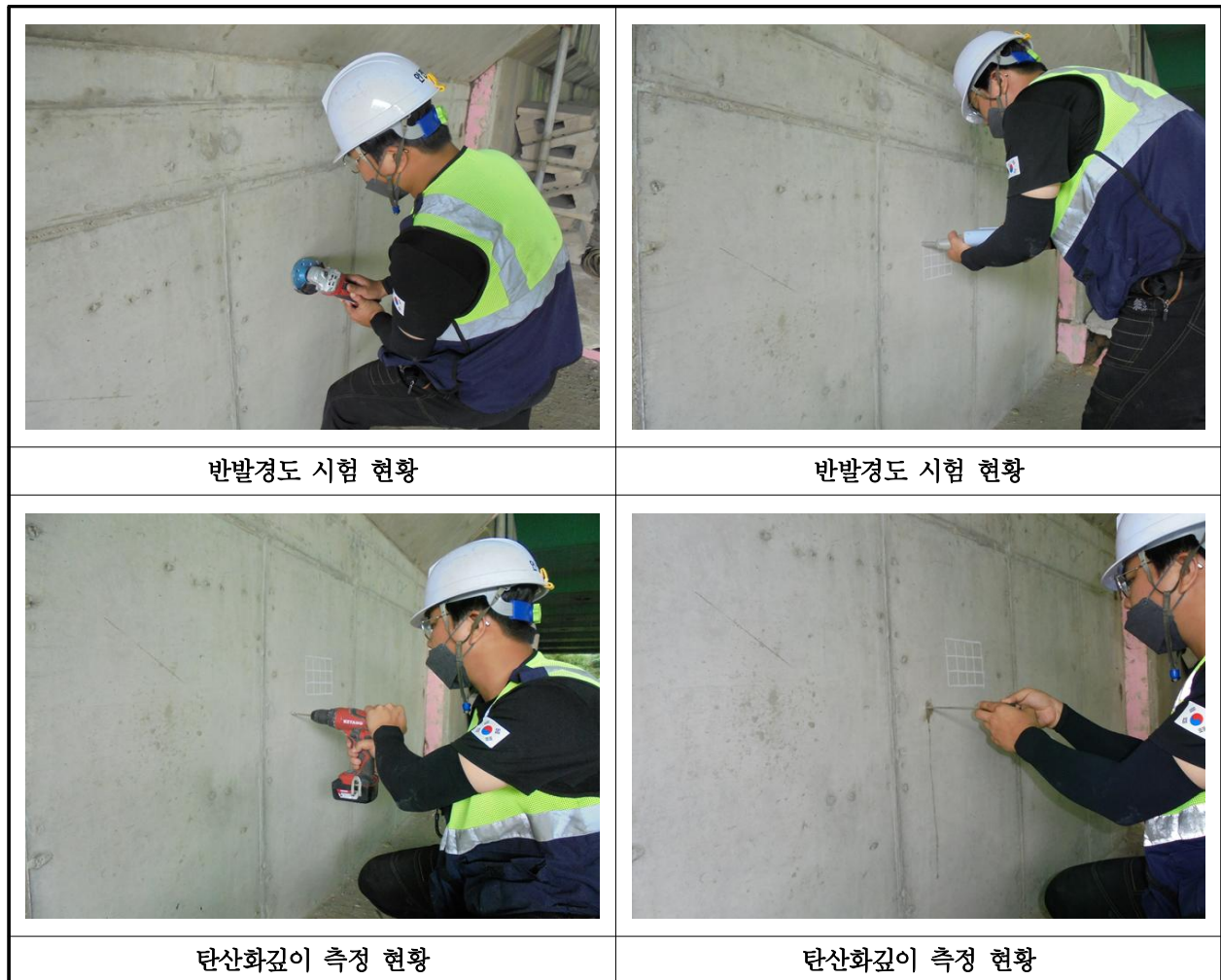
【사진 24.4.1】 콘크리트 내구성조사 현황
