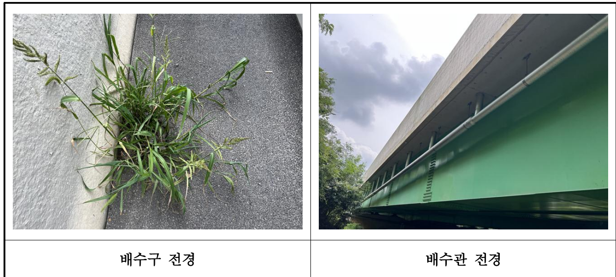
【사진 24.3.21】 배수시설 전경
