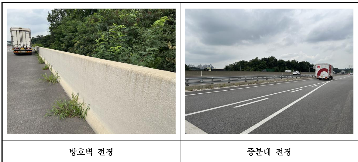
【사진 24.3.23】 방호벽 및 중앙분리대 전경
