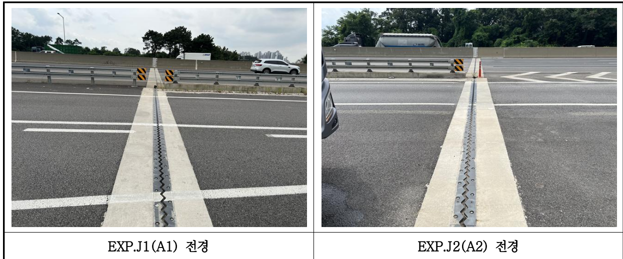
【사진 24.3.16】 신축이음장치 전경
