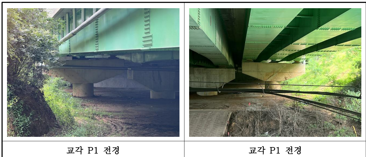
【사진 2.3.10】 교각 전경
