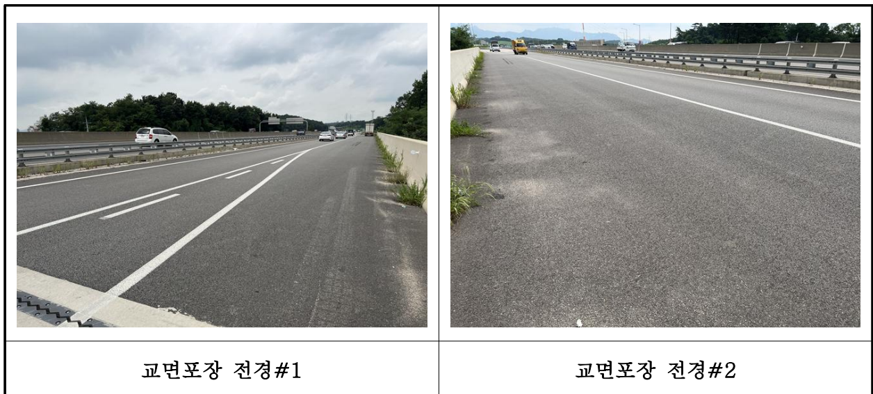
【사진 24.3.19】 교면포장 전경
