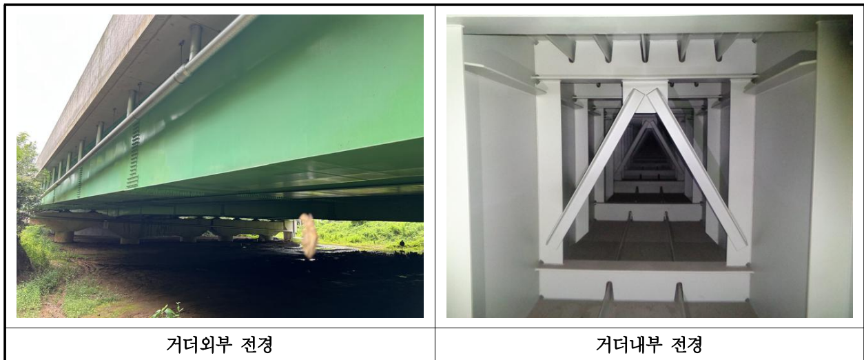
【사진 24.3.4】 거더 전경
